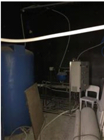
Vista vano occupato dai serbatoi d' acqua del condominio soprastante
